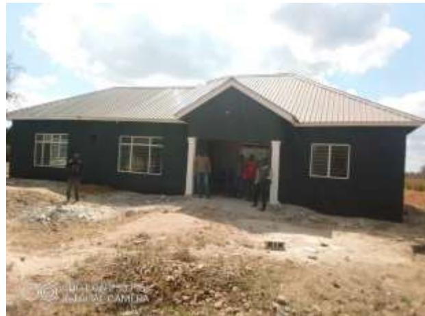
Das fertige außen verputzte Wohnhaus
