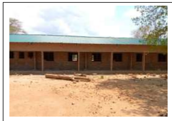
Der Schlaftrakt vor dem jetzt beginnenden Ausbau
