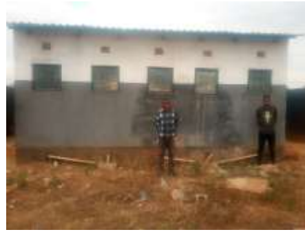
Das Sanitärgebäude ist in Betrieb
