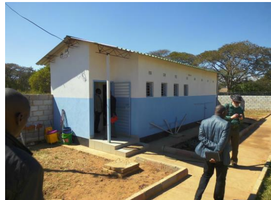
Die Toilettenanlage für beide Schlaftrakts: (Peggy Kabonde I und Peggy Kabonde II). Auch dieses Gebäude befindet sich in einem hervorragenden, sauberen und gut funktion- ierenden Zustand.
