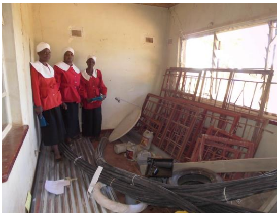
Das Baumaterial, einschl. der ausgebauten Fensterrahmen
