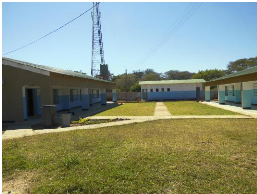
Eine Übersicht des gesamten Projektes: Links: „Unser“ Schlaftrakt Peggy Kabonde I. Hinten in der Mitte: Die Toilettenanlage, von der Schule selbst finanziert. Rechts: Der neue Schlaftrakt Peggy Kabonde II. Er wurde ebenfalls von der Schule finanziert.
