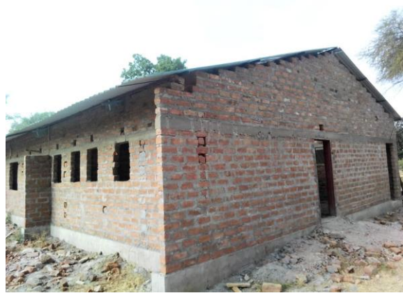
Baustelle im Juni 2020
