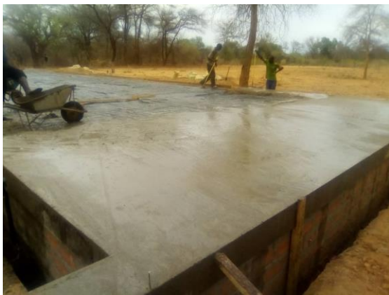
Baustelle im Dezember 2019
