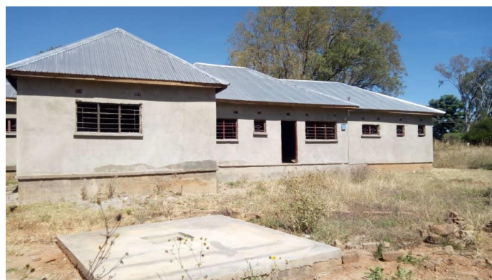
Rückseite Das Foto zeigt auch die Betonplatte der Klärgrube
