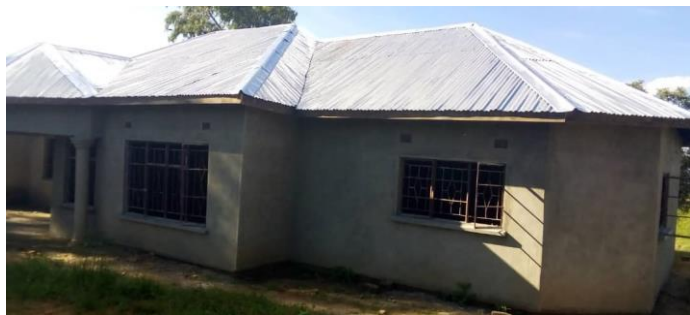
Bau im Mai 2020
