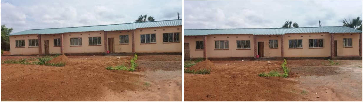
Die Vorderseite (links und rechts) des Dreifamilienwohnhauses zeigt auch hier, dass die Spenden dort ankamen, wofür sie bestimmt waren, auch wenn die Bauphase schwierig war.
