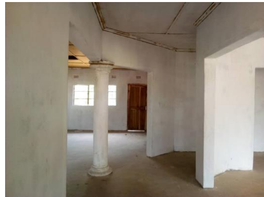
Innengestaltung im November 2020
