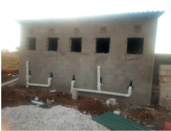
Außeninstallation des Ablutionblocks
