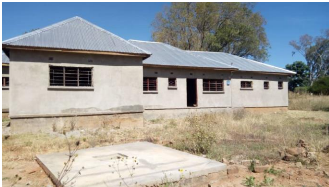
Das Wohnhaus im Sommer 2020
