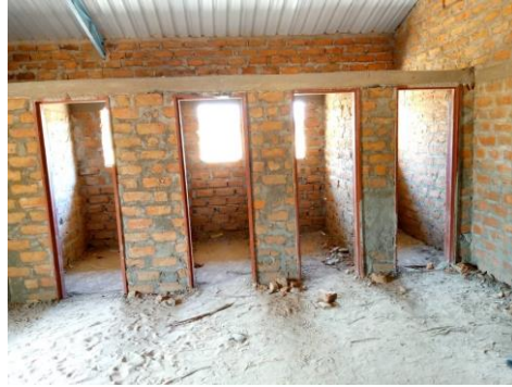
Teil der Toilettenanlage
