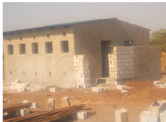
Baustand des Ablutionblocks im Herbst 2020
