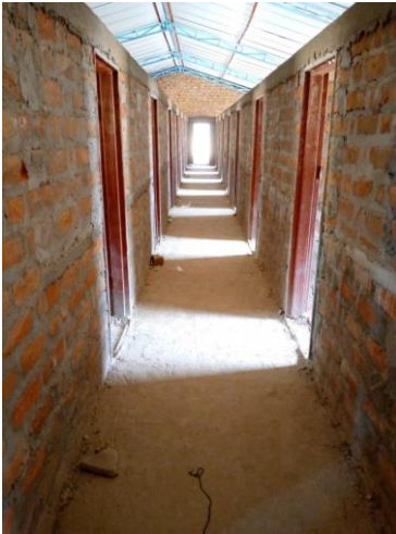
Gang in der Mitte des Gebäudes. Rechts und links die Eingänge zu den Apartments.
